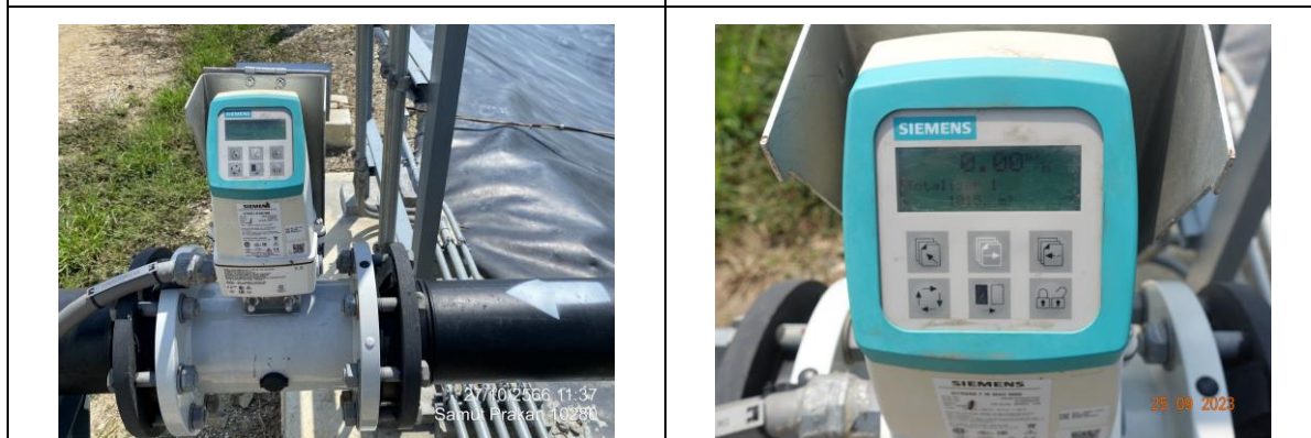
(9) Flow Meter เพื่อวัดอัตราการระบายน้ำทิ้งภายหลังผ่านการบำบัดลงสู่คลองทกส่วน
